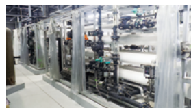
水資源を循環利用する 三重リサイクルセンター 水処理施設 RO 膜処理装置
